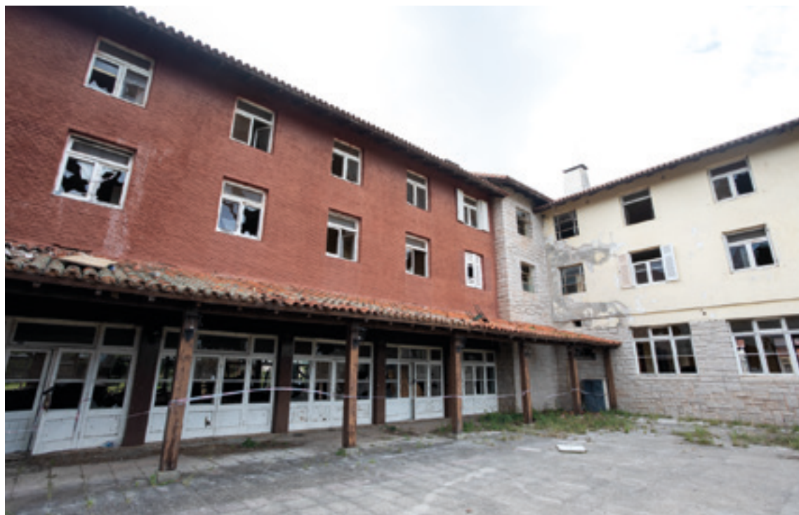
Frente del Hotel 1 de la Unidad Turística de Embalse antes de las obras de puesta en valor. (2022). GUILLERMO LLAMOS. MINISTERIO DE TURISMO Y DEPORTES DE LA NACIÓN.
