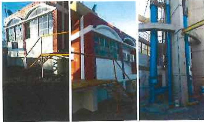
Trabajos de pintura en fachada, sala de tableros, comedor, cañerías y paredes.
