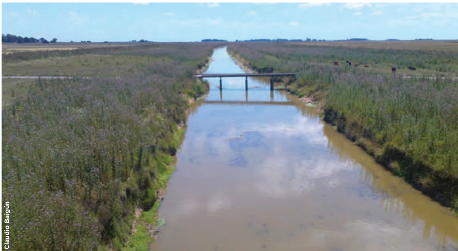
Los canales pampeanos tienen como principal misión evacuar los excesos de agua de las áreas agrícola-ganaderas y poseen cauces rectos, profundos y con alta velocidad de corriente capaces de transportar altas cargas de sedimentos.
