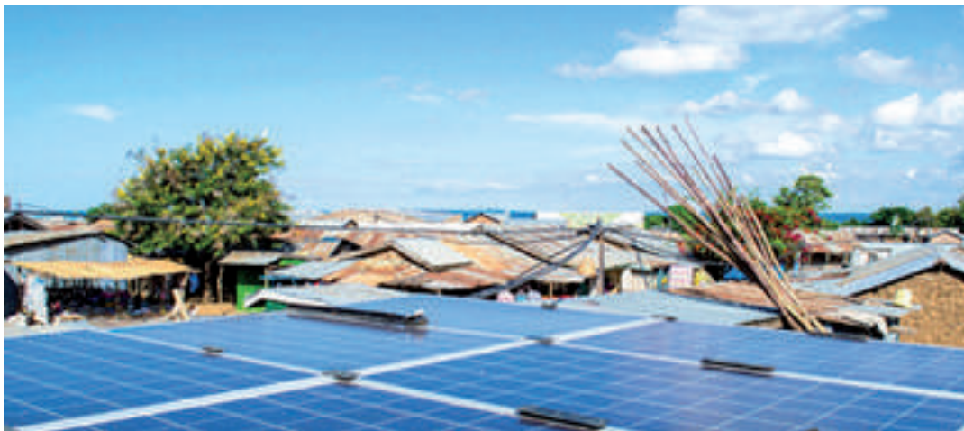
Figura 54: Instalación fotovoltaica SteamaCo.
