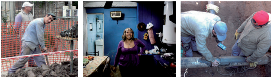
Figura 60: Obras para la conexión de viviendas de Moreno a la red de gas natural. Fuente FPVS
