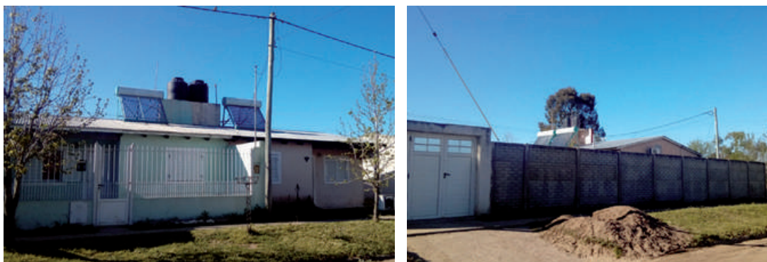
Figura 61: Barrio de bomberos con equipos de calentamiento de agua sanitaria solar, en Bragado. Fuente: Carrizo, 2018
