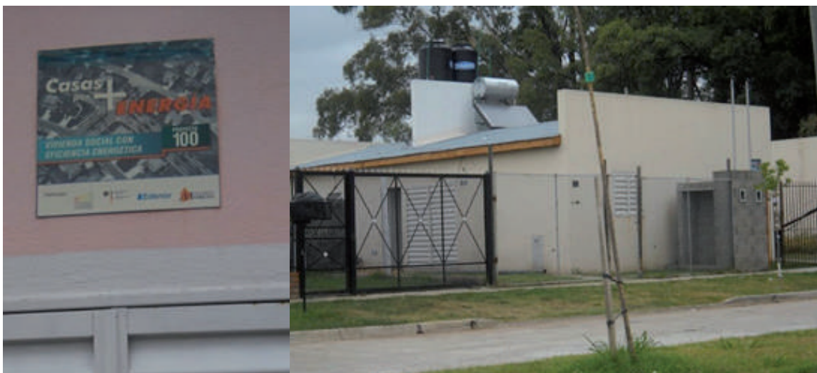
Figura 62: Barrio de viviendas sociales en Moreno, con termotanques solares. Fuente Carrizo, 2013
