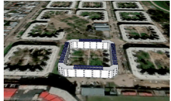
Fig. 48: Instalación solar térmica comunitaria en el barrio San Jerónimo, Santa Fe. Se pueden observar 30 colectores por frente, alimentando a 30 viviendas.
