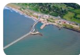
Obras de defensa de costas
