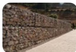
Obras para control de erosión
