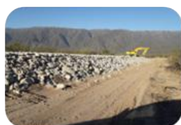
Terraplenes de defensa contra inundaciones
