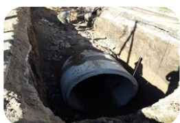
Desagües pluviales urbanos
