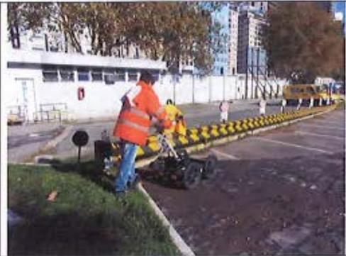
**Fotografía N°2: Relevamiento con Georadar.**
