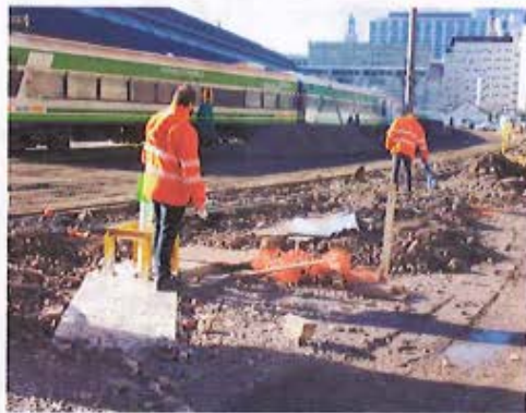
Fotografías N°7: Detección en zona de vías.
