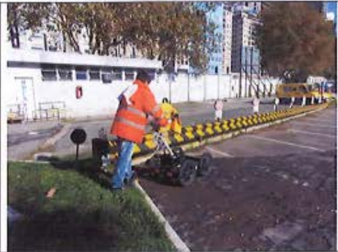
Fotografía N°2: Relevamiento con Georadar.
