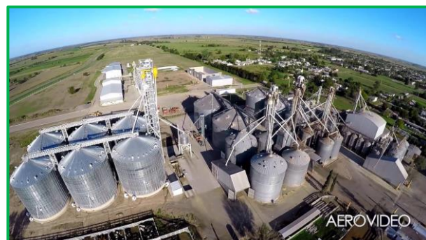
Silos en zona urbana – ingreso
