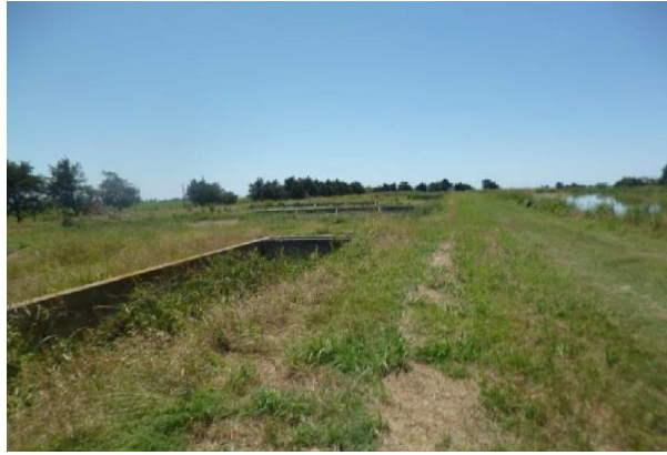
SECTOR DE PILETAS DE RESERVA FUENTE: ARCHIVO COMUNAL
