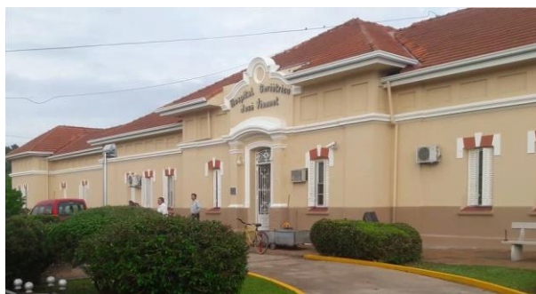
HOSPITAL J. VIONET FUENTE: ARCHIVO COMUNAL
