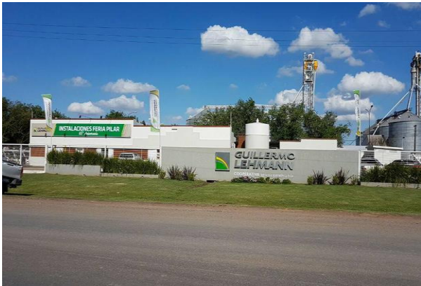
Coopertativa Lehmann Silos - Granos FUENTE: Web Lehmann
