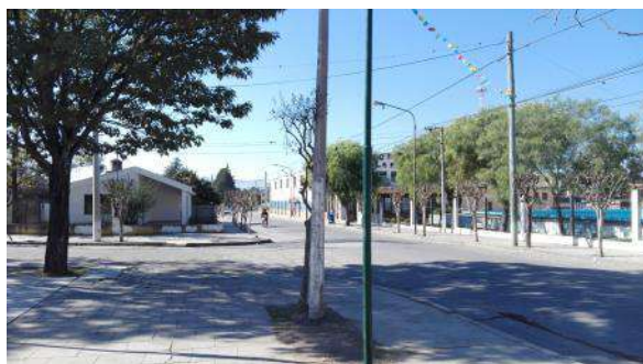
Iluminación calles de borde de la Plaza Principal. Fotografía propia.
