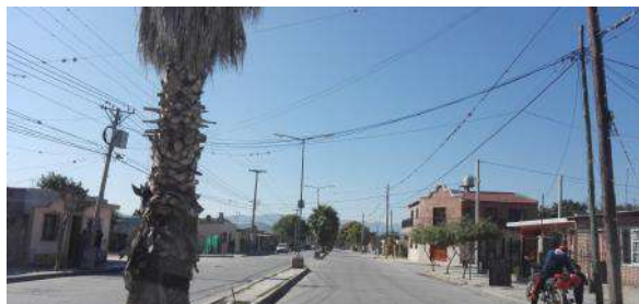
Iluminación Av. Sarmiento – Ruta Provincial N°22. Fotografía propia.
