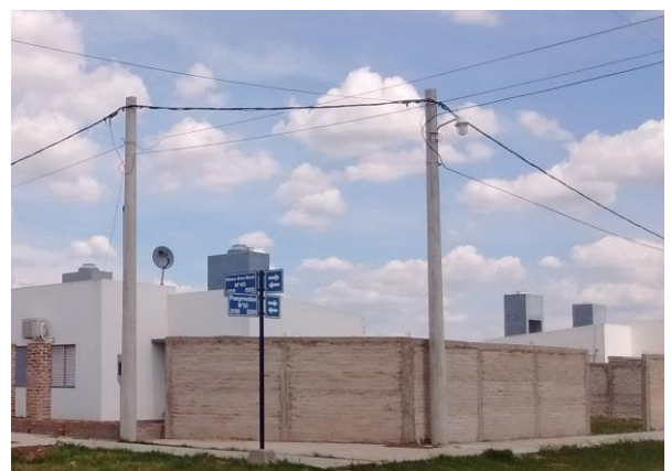
Columna Alumbrado con artefactos colgantes ajustados con brazo
