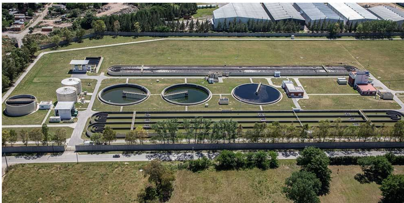
Imagen 27: Foto aérea Planta las Catonas
