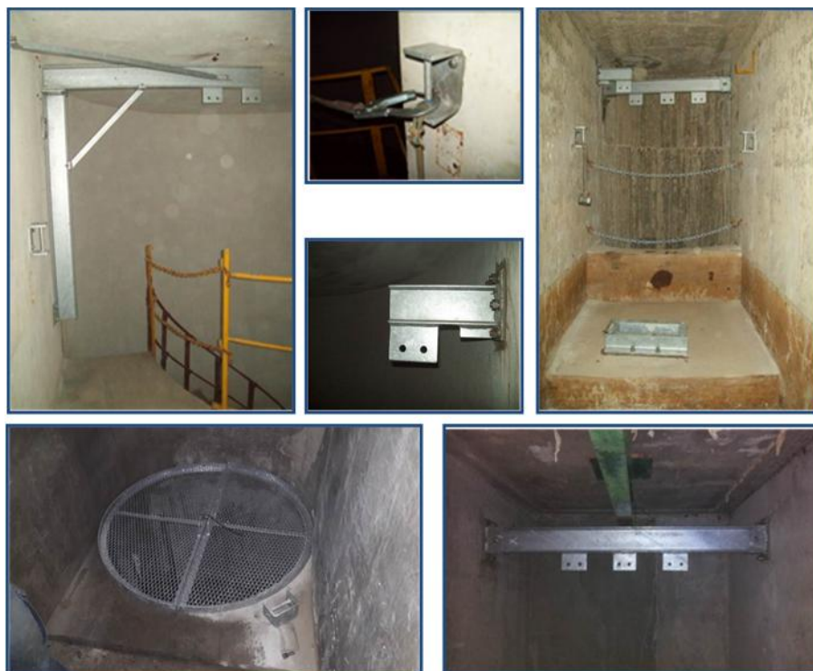
Imagen 7: Trabajos de rehabilitación de cámaras de accesos a Ríos Subterráneos
