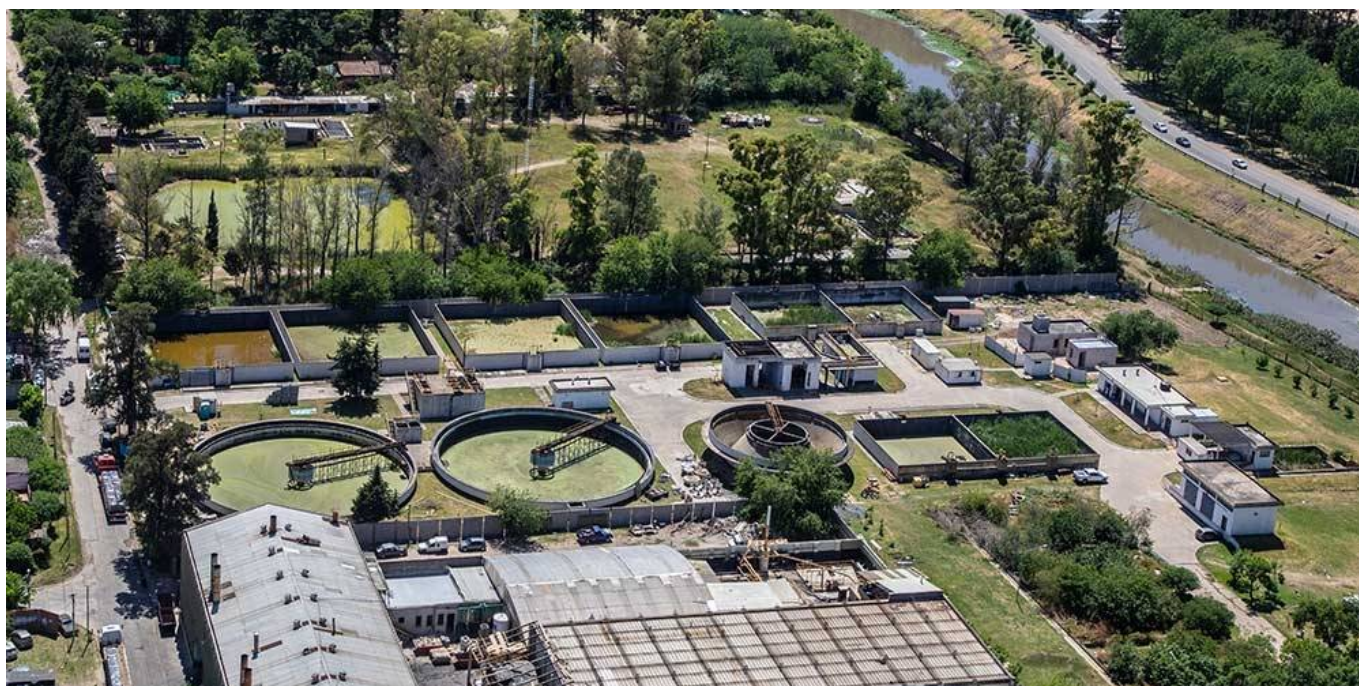
Imagen 29: Foto aérea Planta Paso del Rey
