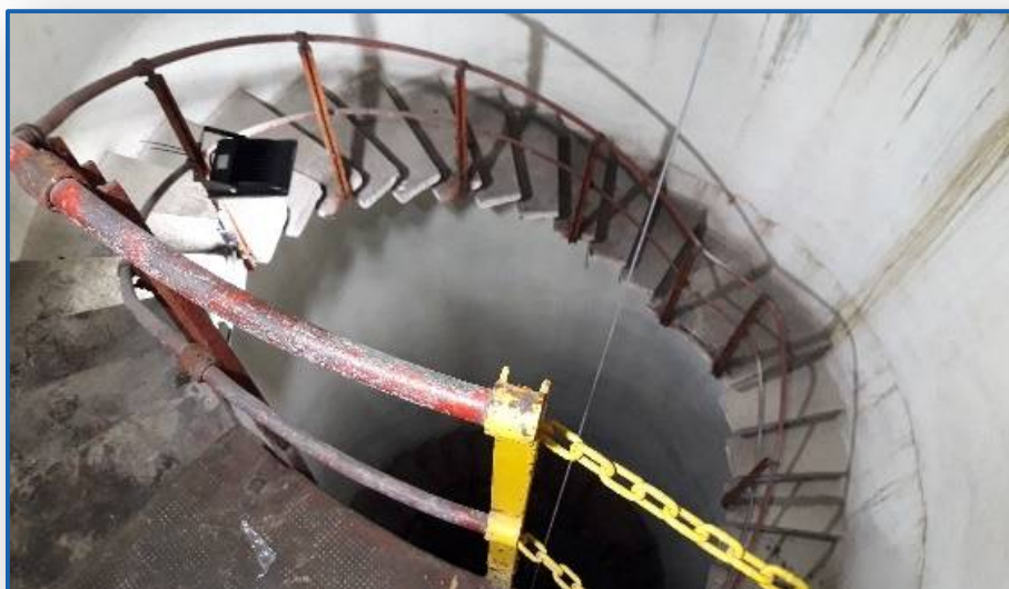
Imagen 6: Cámara de acceso Río Subterráneo
