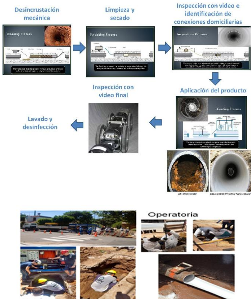
Imagen 13: secuencia rehabilitación de redes con recubrimiento poliurea
