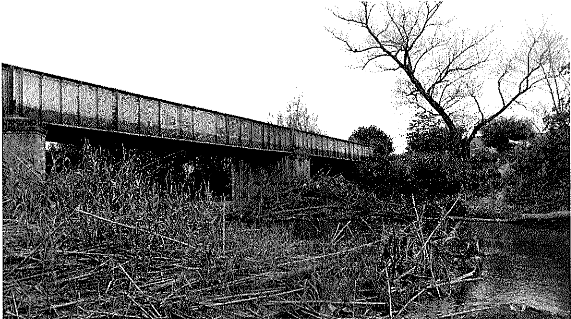
Vista de dos tramos desde aguas arriba (tramo derecho a reemplazar).
