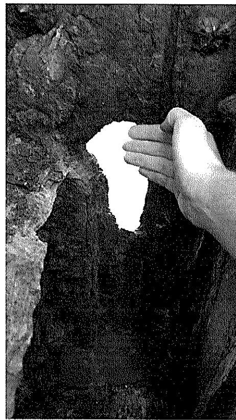
Corrosión en zona de apoyo Tramo N° 2
