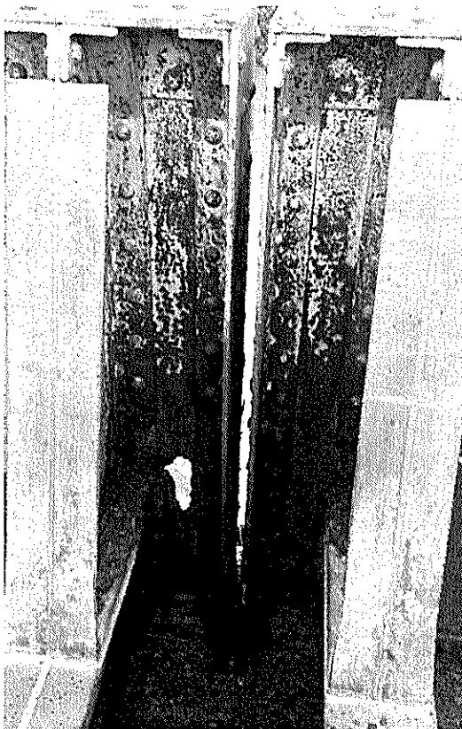
Corrosión en zona de apoyo Tramo N° 2
