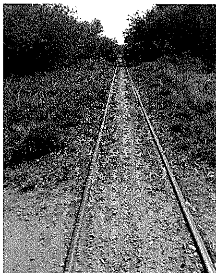
Vía sobre terraplén lado sur a renovar
