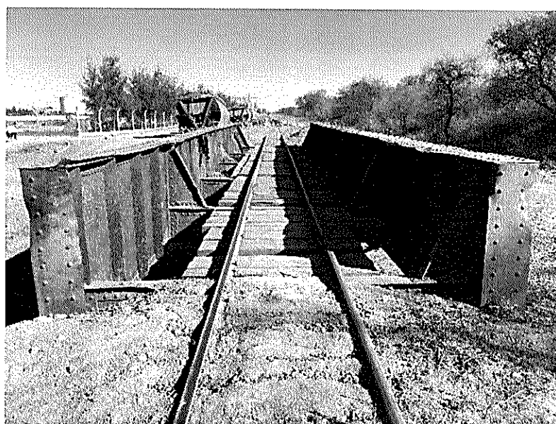
Vista general del puente y estructura de vía
