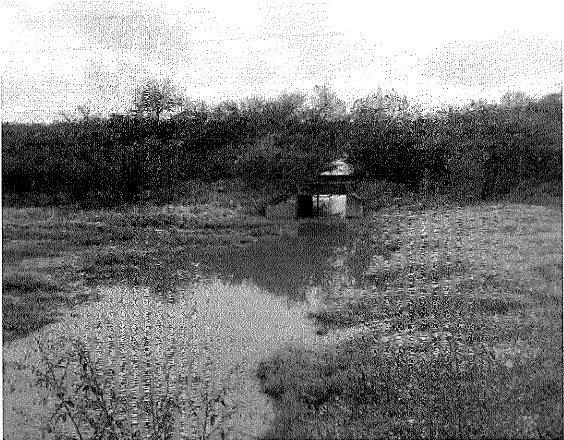
Alcantarilla aguas debajo de la RN 157
