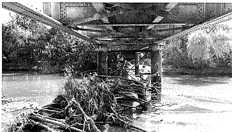
Vista de pilas intermedias y maleza a retirar
