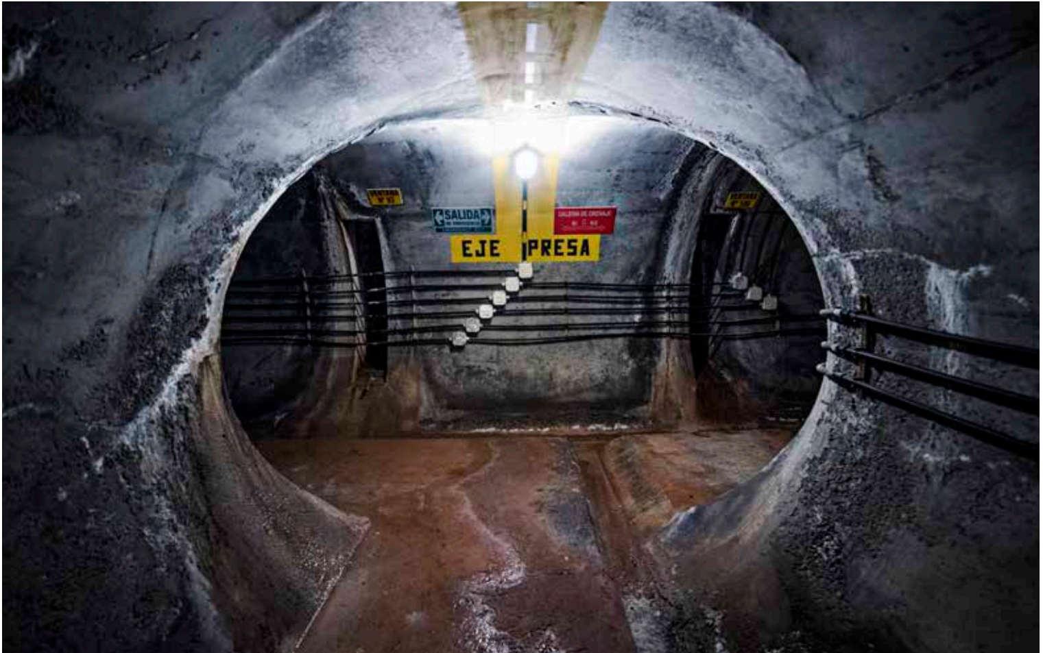
Arriba y página siguiente: galería de inspección y drenaje, Planicie Banderita, Neuquén.
