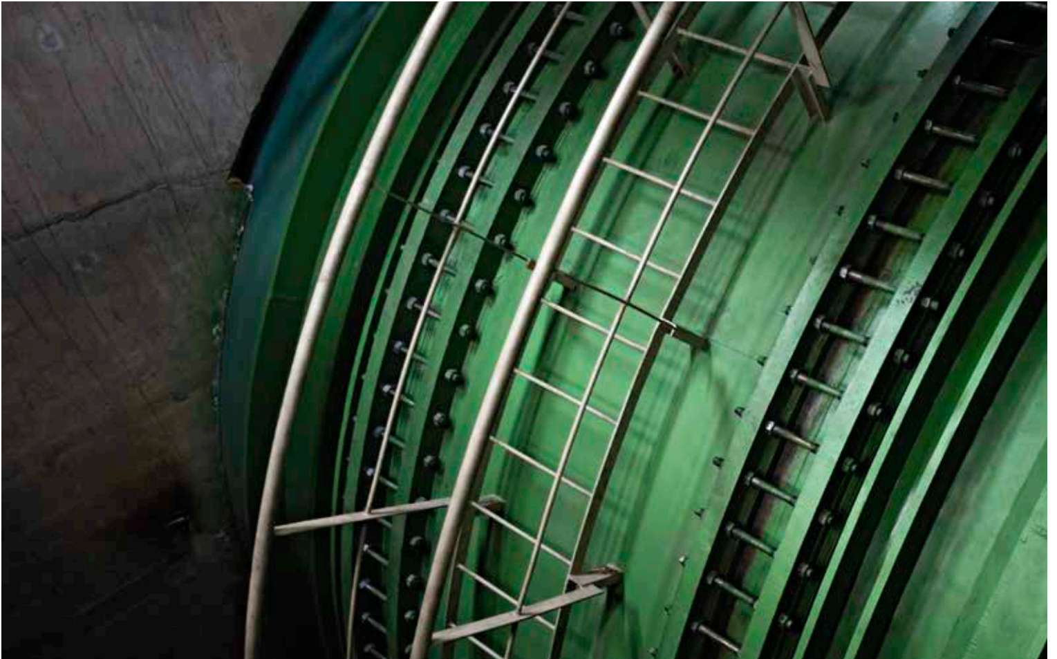
Bridas de acople de tubería de aducción, Piedra del Águila, Neuquén y Río Negro.
