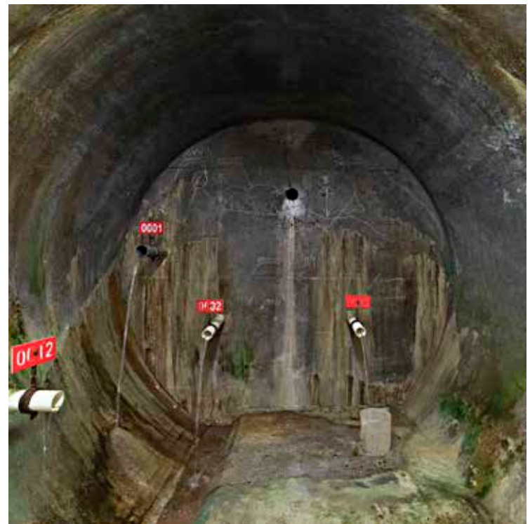
Descarga de drenaje, Planicie Banderita, Neuquén.
