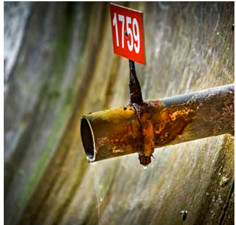
Descarga de drenaje, Planicie Banderita, Neuquén.
