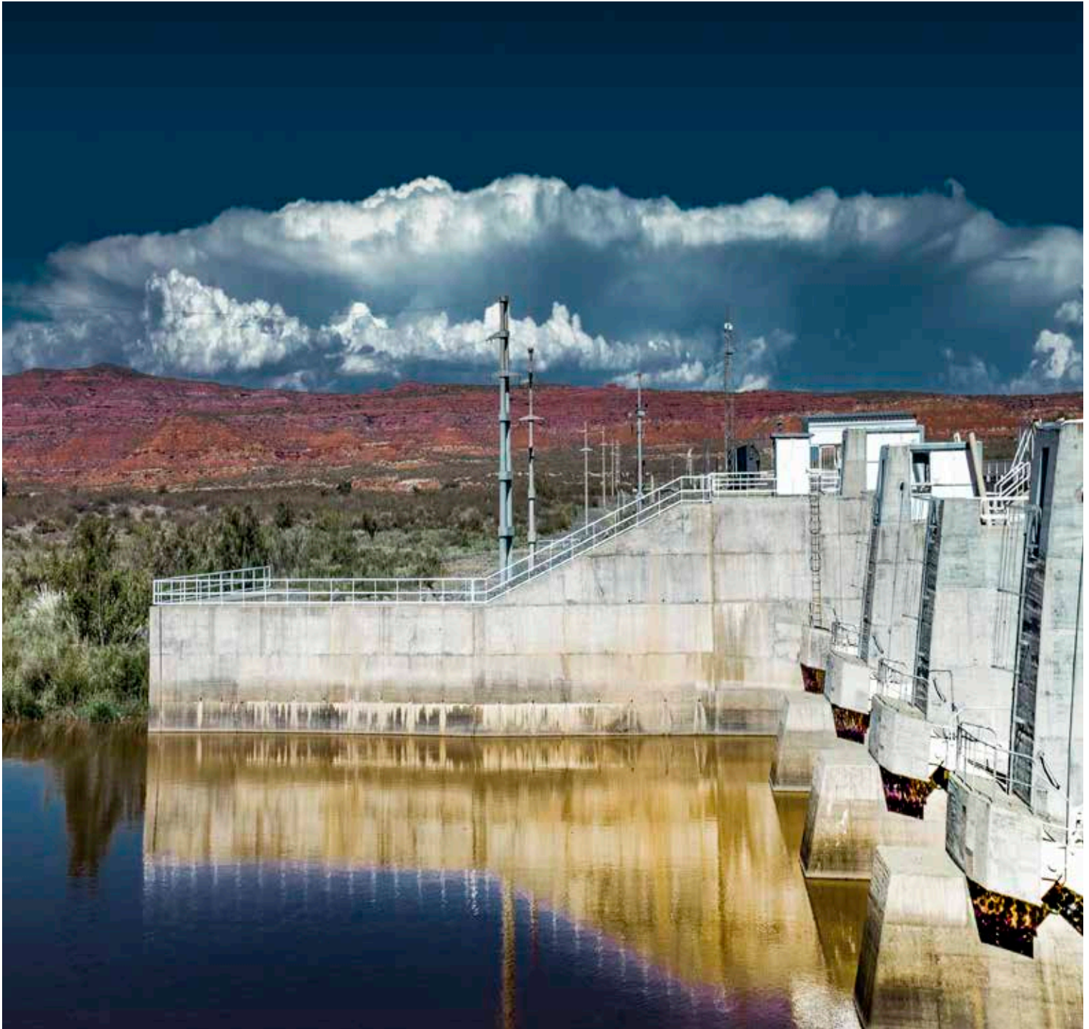
Restitución de la presa derivadora de Portezuelo Grande, complejo Cerros Colorados, Neuquén.
