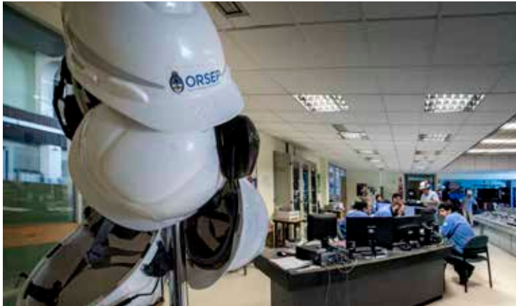
Sala de control, Central hidroeléctrica El Chocón.
