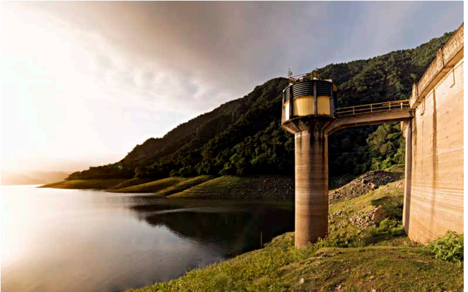
Torre de toma y embalse deprimido, complejo Escaba, Tucumán.
