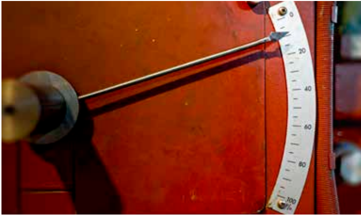
Indicador de grado de apertura de compuerta, Planicie Banderita.
