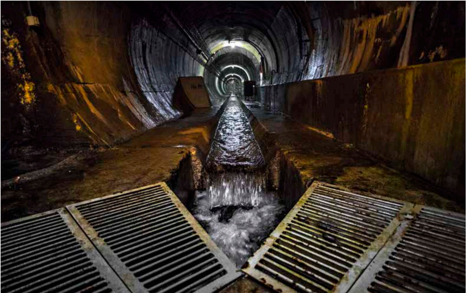
Galería de inyección del paleocauce GP3, Piedra del Águila, Neuquén y Río Negro.
