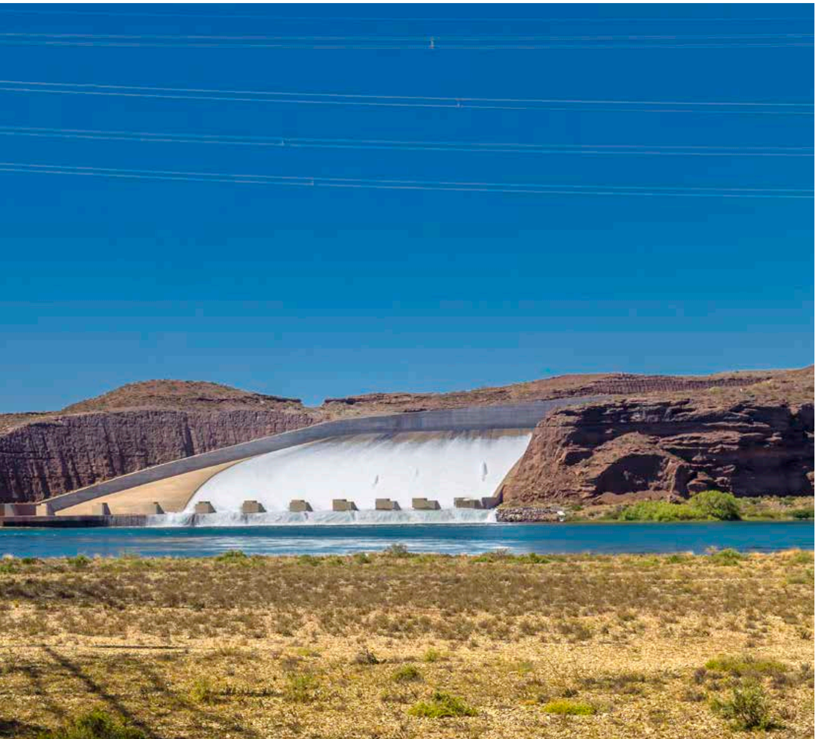
Vertedero erogando agua del embalse durante un ensayo de funcionamiento de compuertas, El Chocón, Neuquén y Río Negro.
