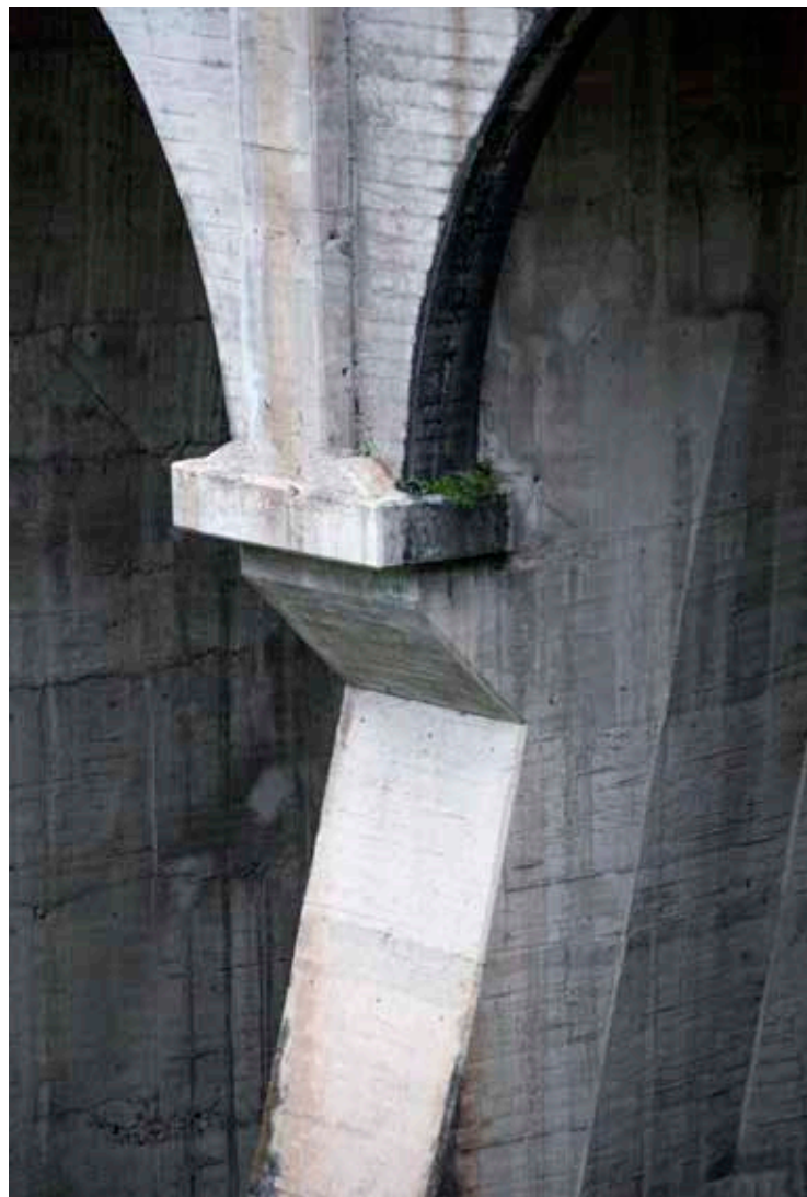
Arriba: Contrafuerte del dique Escaba, Tucumán. Izquierda: Embalse y dique Escaba, Tucumán.
