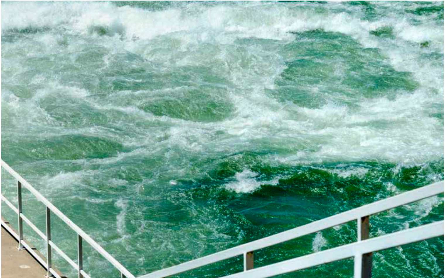
Camino de servicio sobre el muro de ala de margen izquierda, El Chañar, Neuquén.
