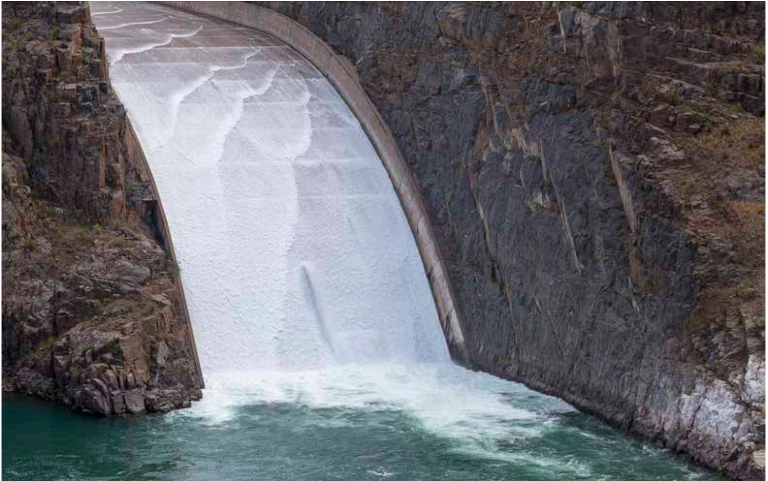
Vertedero del complejo Los Reyunos durante una maniobra de ensayo de funcionamiento de compuertas, Mendoza.
