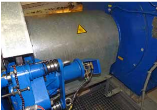
Figura 2. Resguardo de protección acoplamiento alta velocidad.
