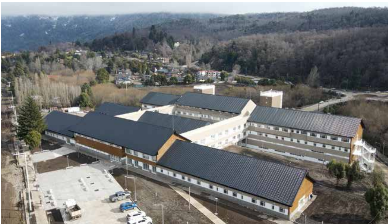
Nuevo Hospital Dr. Ramón Carrillo, San Martín de los Andes, provincia de Neuquén.
