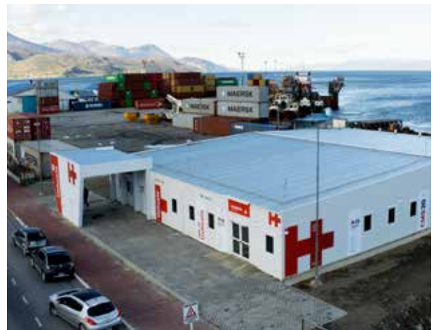
Centro Modular Sanitario de Ushuaia, provincia de Tierra del Fuego, Antártida e Islas del Atlántico Sur.
