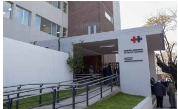
Nuevas áreas de Obstetricia y Pediatría en el Hospital Thompson de San Martín, provincia de Buenos Aires.
