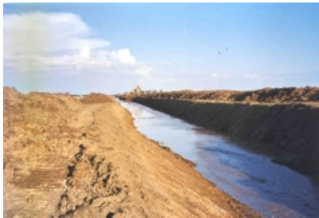
Canal para la protección de la Ciudad de Vicuña Mackenna - Provincia de Córdoba
