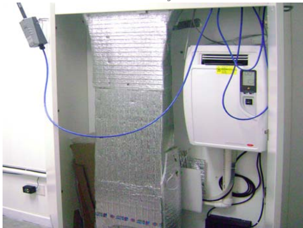
Módulo de acondicionamiento de aire ingresante a la Cámara Climatizada.
