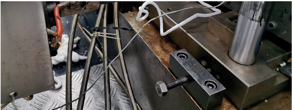
Apertura de tornillo durante la purga.
