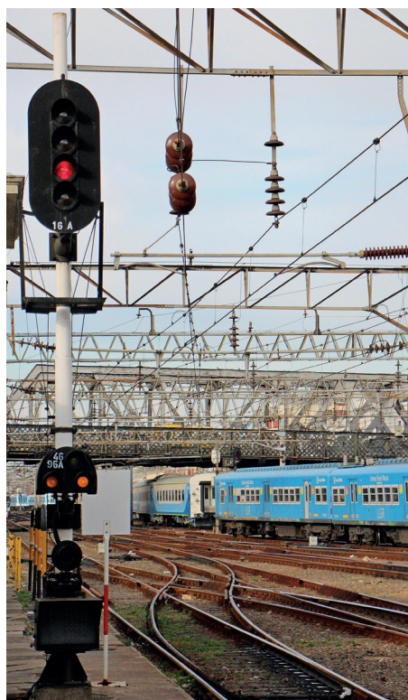
Ramal ferroviario eléctrico (catenaria).
