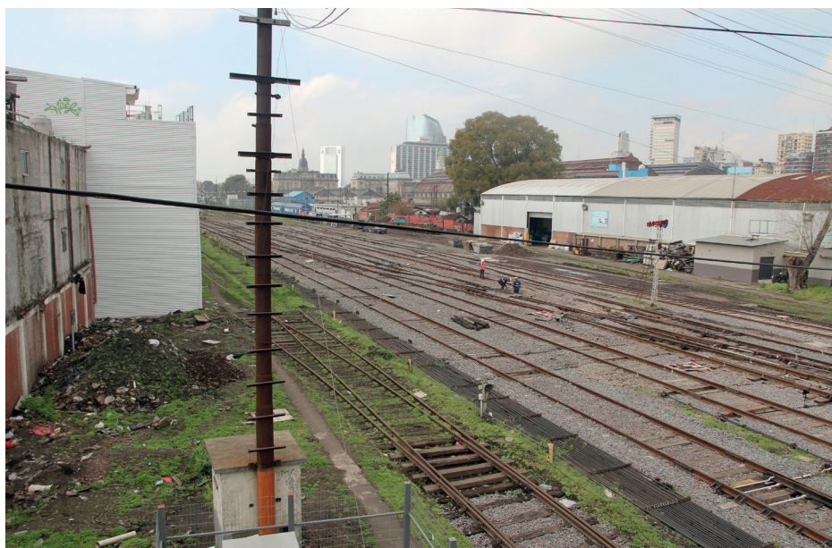
Vista aérea de zona de vías.
