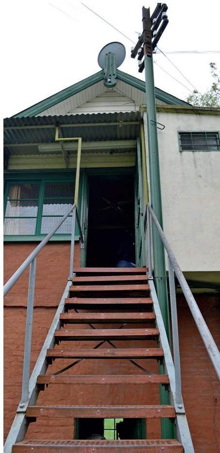
Acceso a cabina a través de una escalera de estructura metálica.
