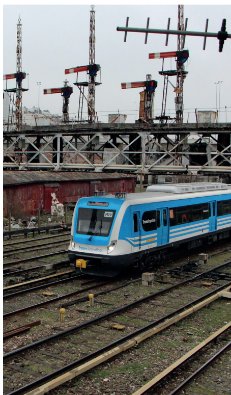
Protección del tercer riel con tensión (electrificado).
