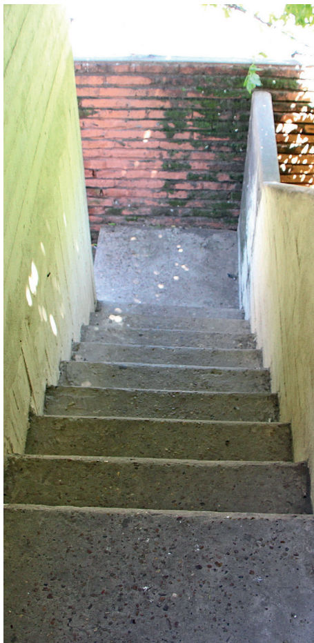
Acceso a cabina a través de una escalera de hormigón.
