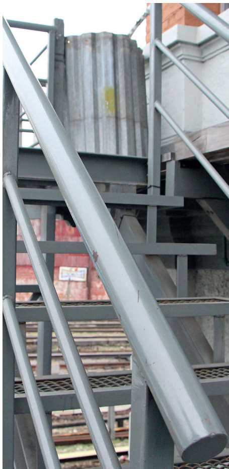
Acceso a cabina por medio de una escalera de estructura metálica.
