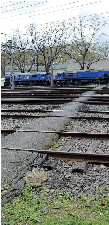
Sendero alternativo de circulación peatonal.
