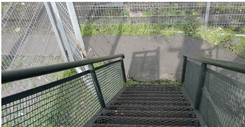
Escalera de acceso a la cabina de señales.
