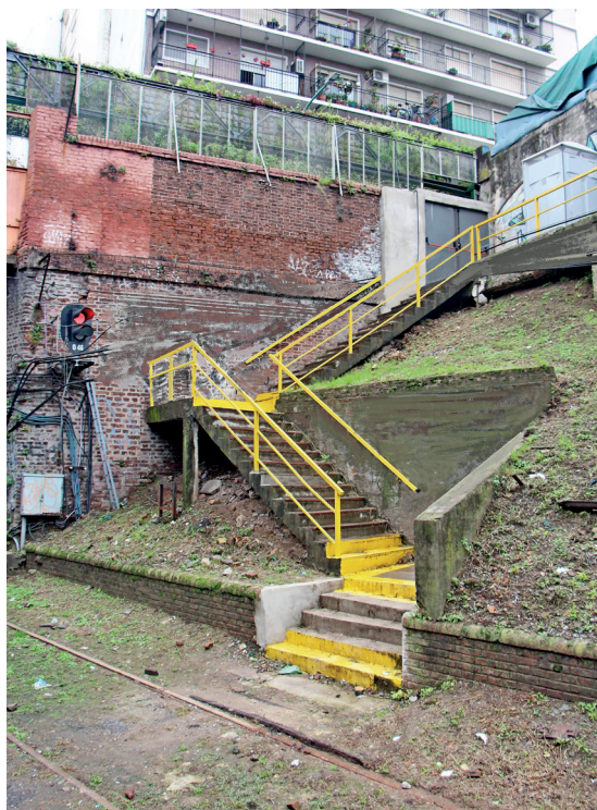
Escalera de acceso desde la vía pública
