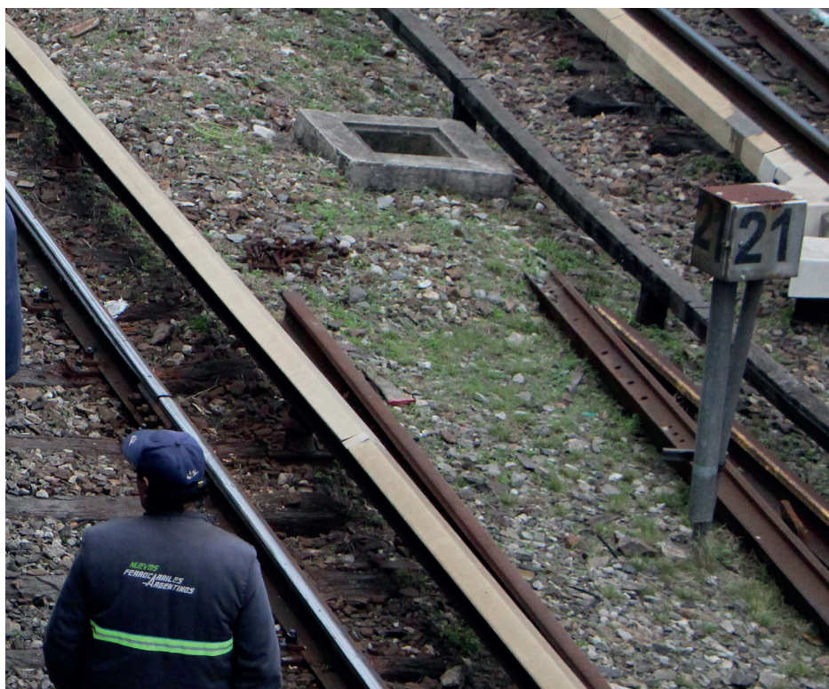
Caminos alternativos de superficie irregular para acceder al sector de cabinas y/o zonas de vías
