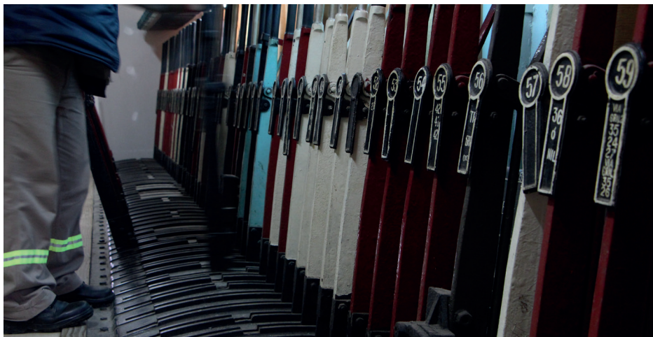
Posición normal de palancas de accionamiento mecánico.
