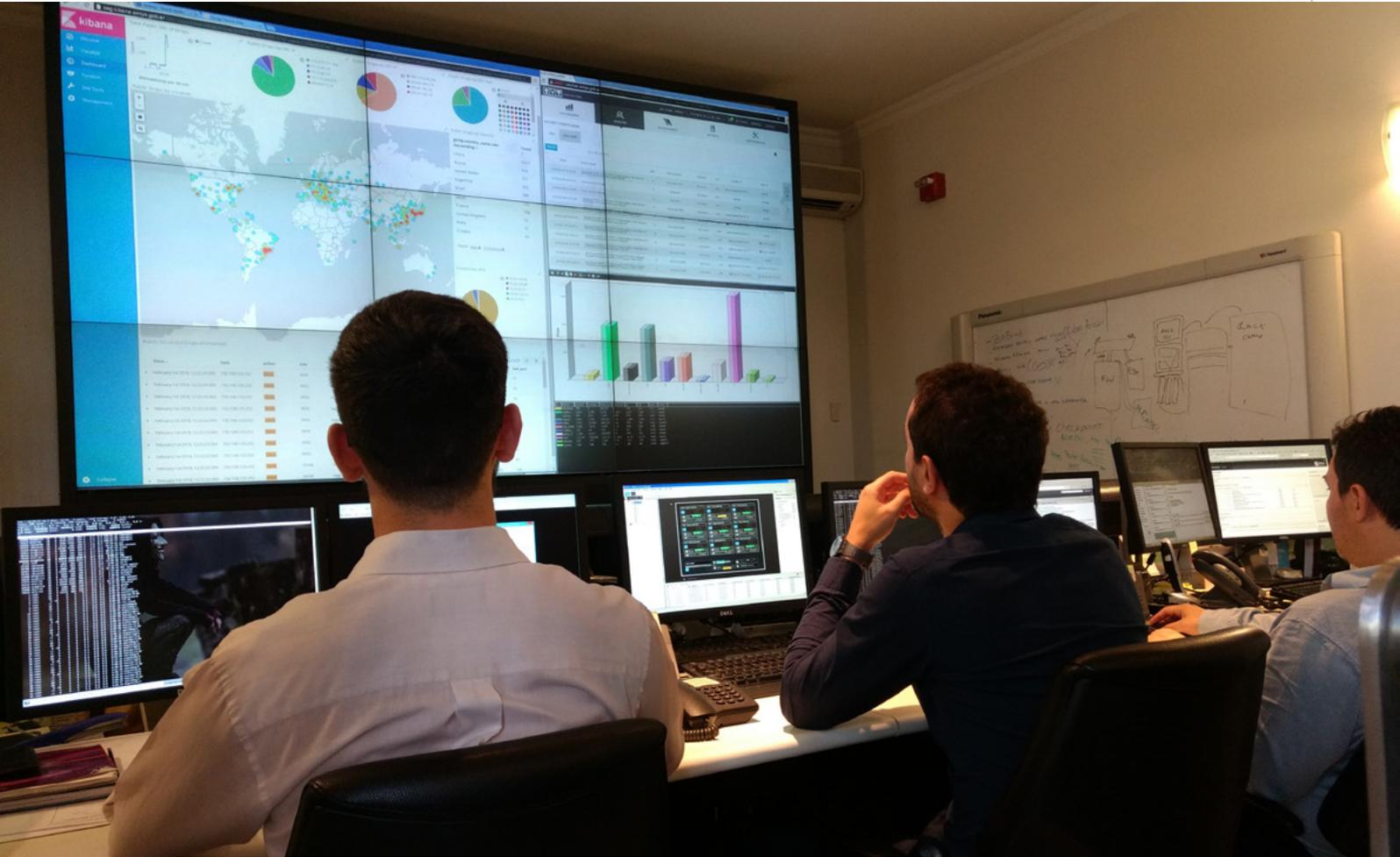
En el primer ensamblado de la sala de monitoreo, NOC (Network Operations Center) / SOC (Security Operations Center), el Video Wall estaba conformado por 6 pantallas de retroproyección led, de 50 pulgadas en HD que permitía monitorear el funcionamiento de los sistemas, las conexiones y las amenazas de seguridad. Una vez finalizado, el Video Wall cuenta con 9 pantallas.
