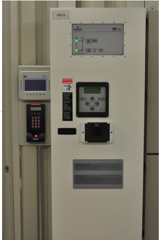
Uno de los tableros de llaves térmicas instalados en la sala. Todas las líneas eléctricas cuentan con protección térmica. ATS (Automatic Transfer Switch): este sistema transfiere la conexión de línea al generador cuando se corta la energía de red. En conjunto con las UPS (Uninterruptible Power Supply) mantienen la energía eléctrica del centro de cómputos funcionando 7x24.
