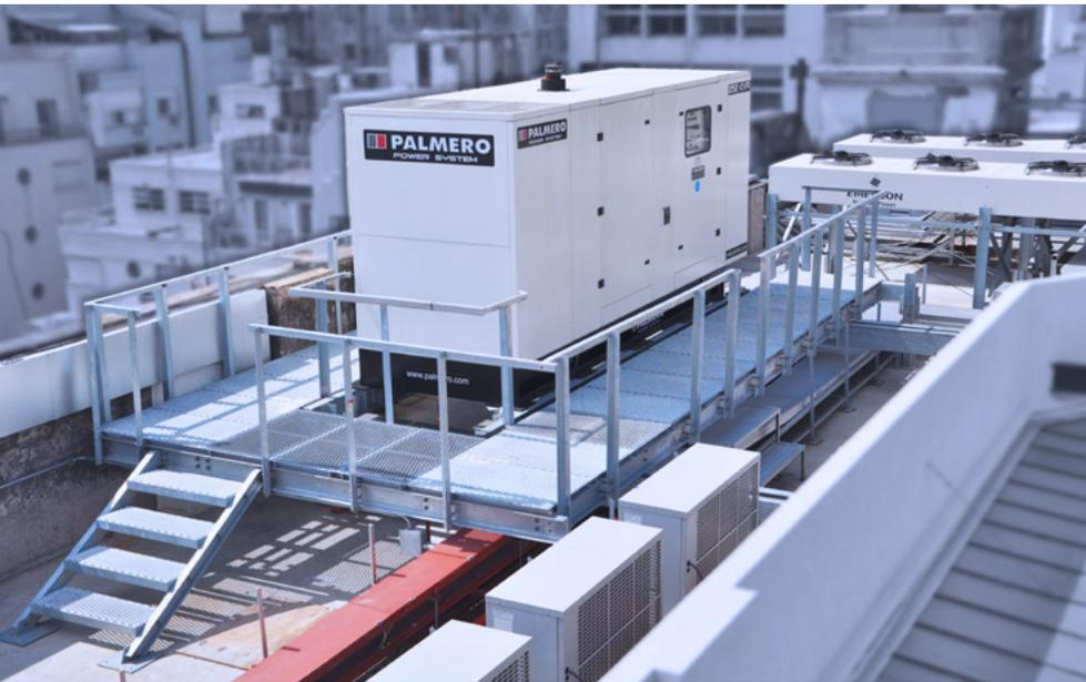
En la terraza del edificio se montó un sistema de enfriamiento para la Sala Cofre. Las condensadoras debieron ser subidas a la terraza mediante grúas industriales.
