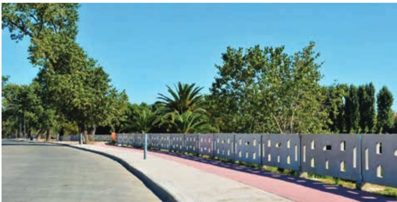
Figura 10: Estado actual de las obras de la costa de Valentín Alsina en las cercanías del puente.
