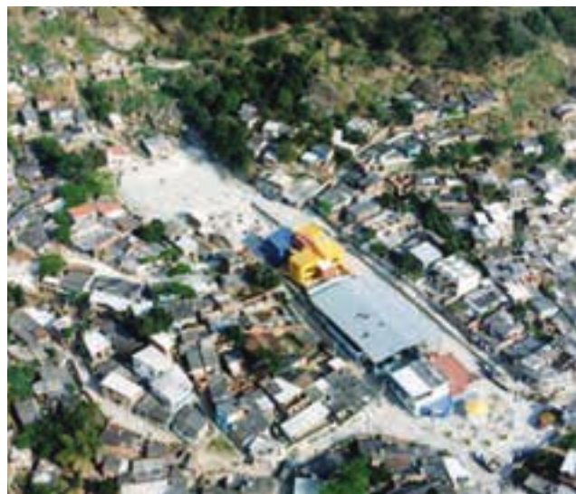
Núcleo de la intervención de urbanización en favela Campinho, en Rio de Janeiro.
