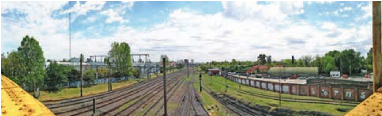
Figura 4: Vista panorámica de la playa de maniobras de Remedios de Escalada desde el ex puente carretero
