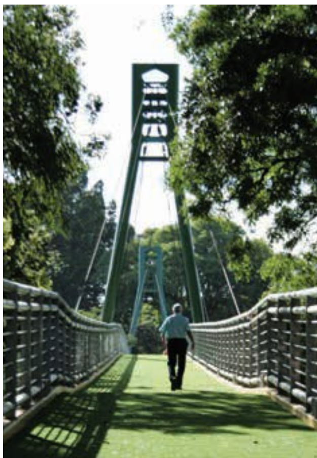
Figura 11: Puente peatonal Dorrego
