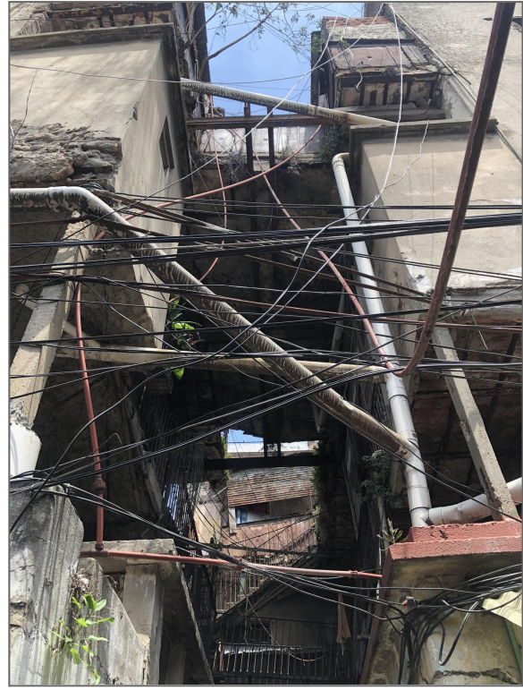
Imagen 4 a 7 - Estado y formas de conexión internas de instalaciones de energía eléctrica, sanitarias, etc.
