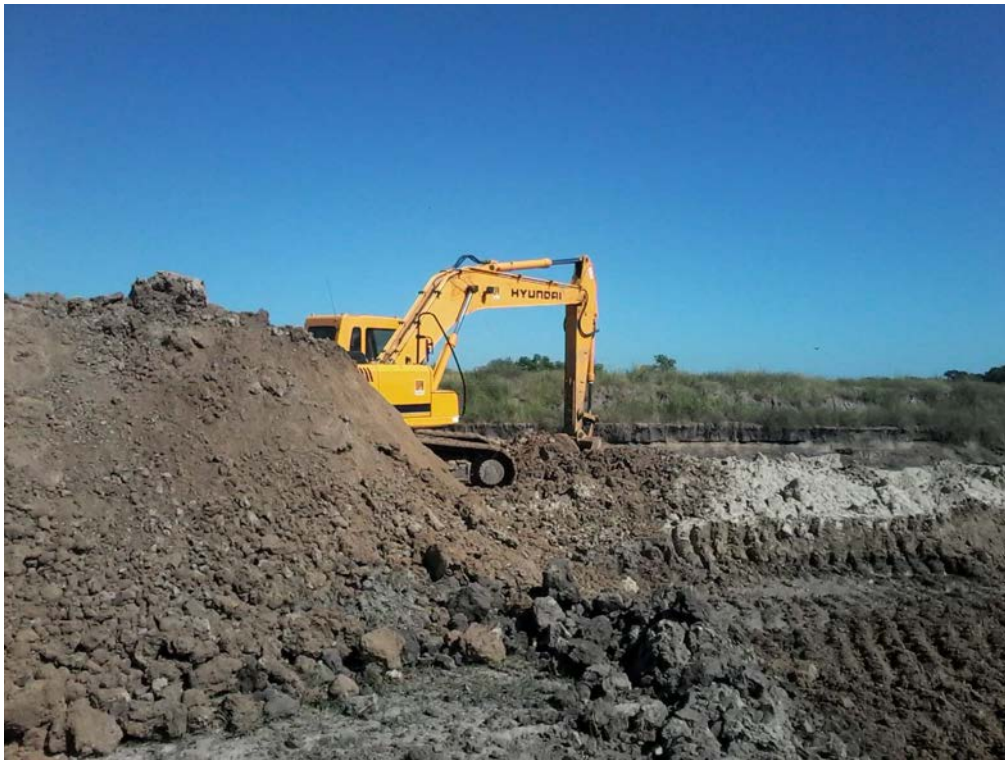
Construcción de las celdas del relleno sanitario del Complejo Ambiental
