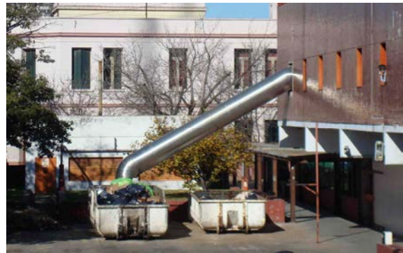
Tolva de descarga de residuos comunes: boca de carga (izquierda) y vista exterior (derecha)
