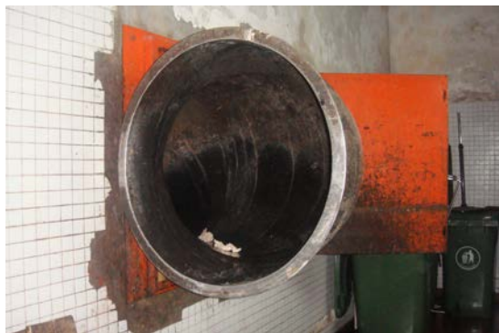
Tolva de descarga de residuos comunes: boca de carga (izquierda) y vista exterior (derecha)
