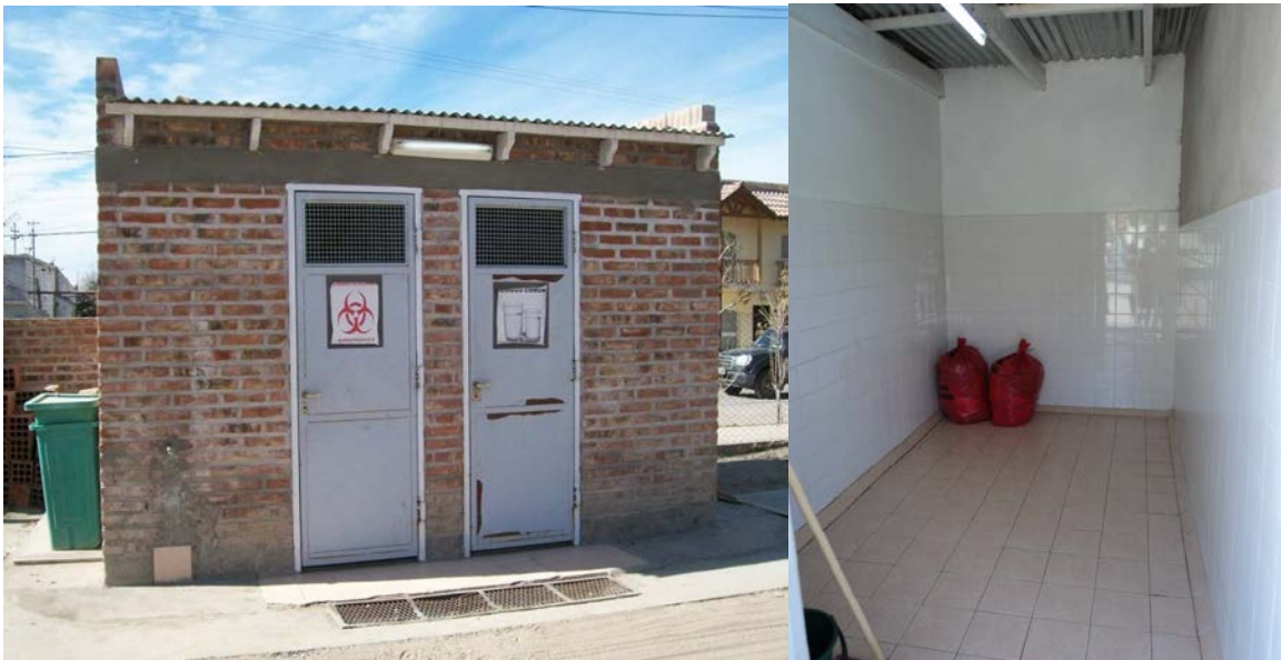
Almacenamiento final de residuos biopatogénicos
