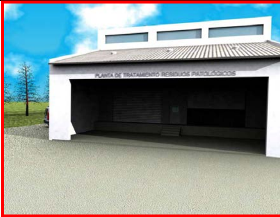
Frente de la Planta de Tratamiento
