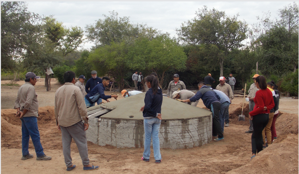
Jornada de construcción de cisterna en el paraje San Antonio de Copo, Santiago del Estero.
