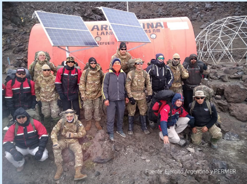
Figura 7. Instalación y mantenimiento de paneles solares en instalaciones del Ejército Argentino (2019)
