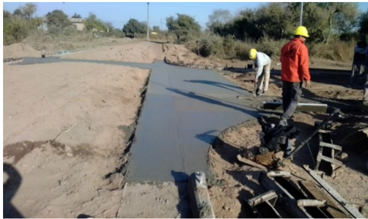
Ilustración 2 Ejecución de Infraestructura - Proyecto Ecobarrio.
