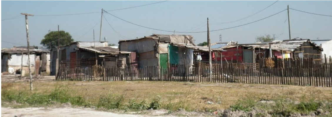
Foto 1. Situación inicial. Puede observarse el tendido eléctrico precario, conexiones clandestinas y las unidades habitacionales con cerramientos de chapas de cartón o bolsas de plástico. Municipio de Formosa.
