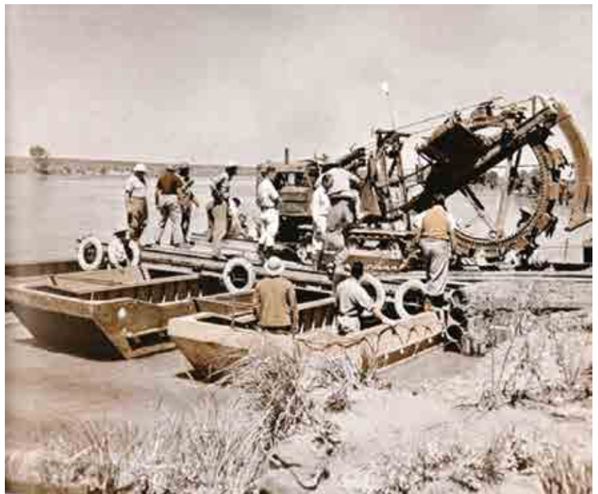
Obra del Gasoducto Presidente Perón, iniciada en 1947 e inaugurada en 1949, que recorre 1.605 kilómetros desde Comodoro Rivadavia hasta la ciudad de Buenos Aires.
