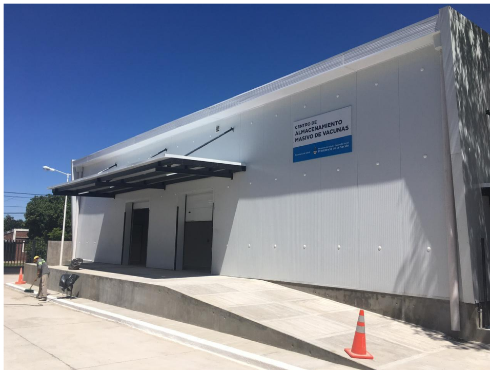
Figura 2-7: Centro Provincial de Almacenamiento de Vacunas Existente en Chaco
