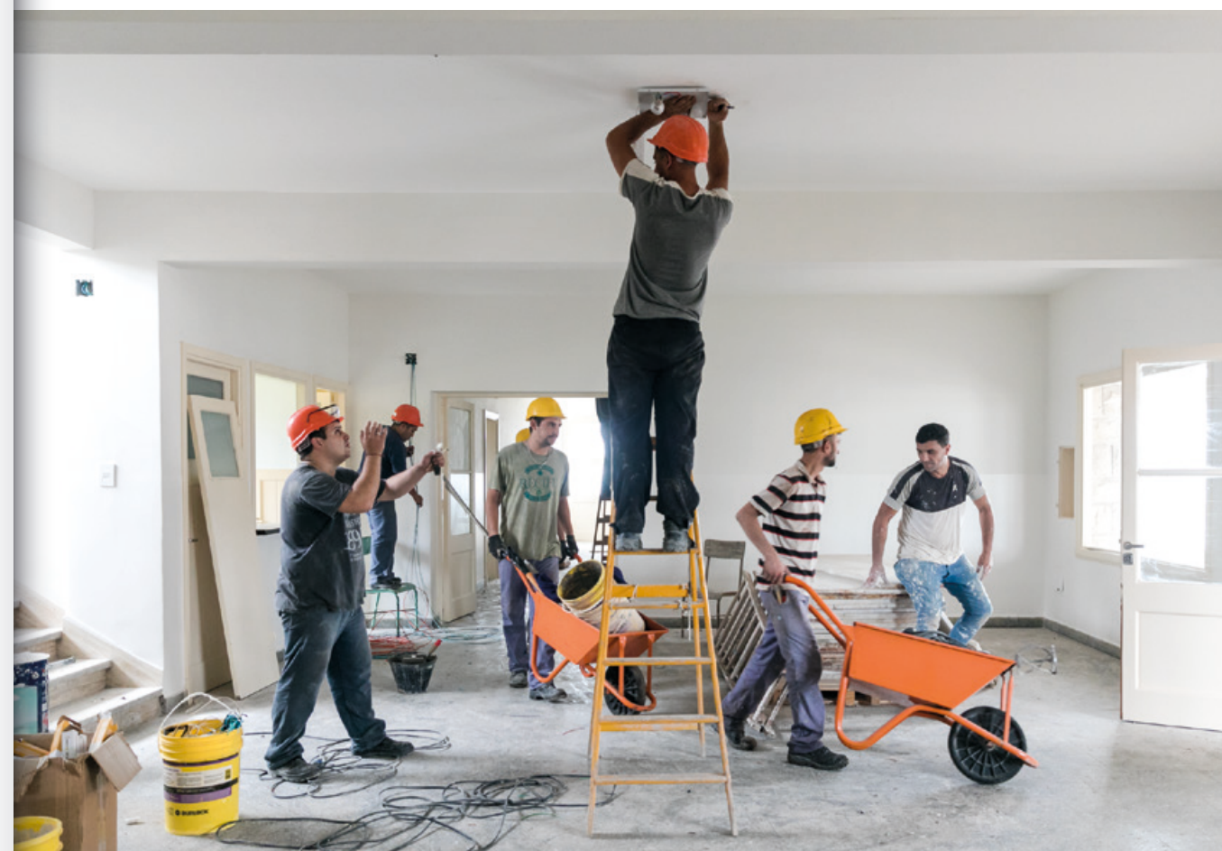
Recepción del Hotel 6 de la Unidad Turística de Chapadmalal durante las obras de refacción y puesta en valor. (2022). ESTRELLA HERRERA. MINISTERIO DE TURISMO Y DEPORTES DE LA NACIÓN.
