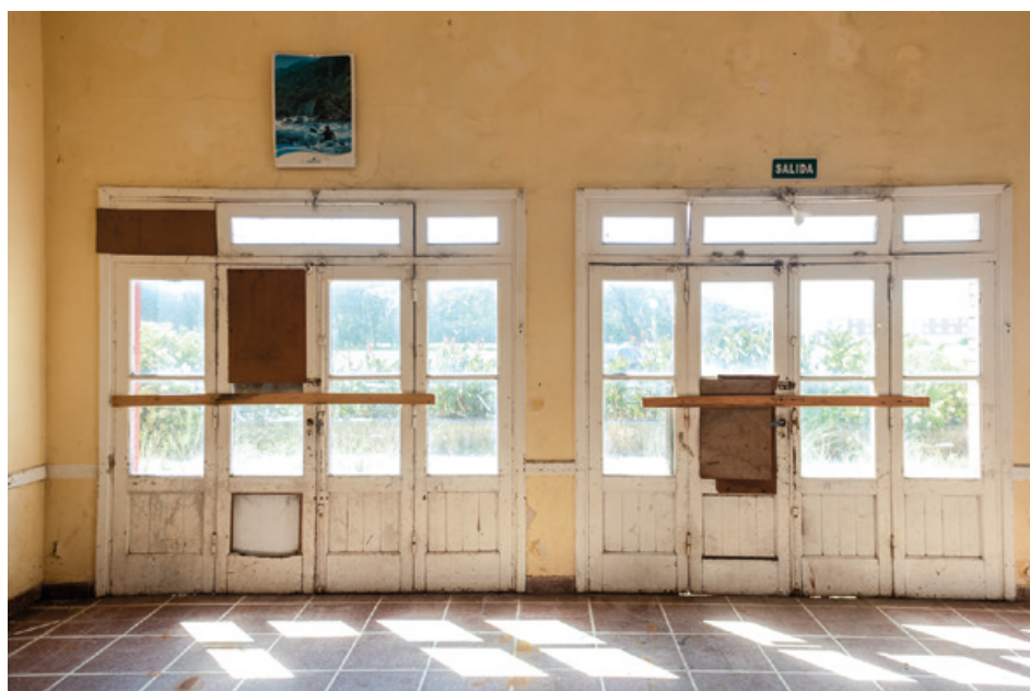
Interiores del Hotel 1 de la Unidad Turística de Embalse antes de las obras de puesta en valor. (2022). GUILLERMO LLAMOS. MINISTERIO DE TURISMO Y DEPORTES DE LA NACIÓN.
