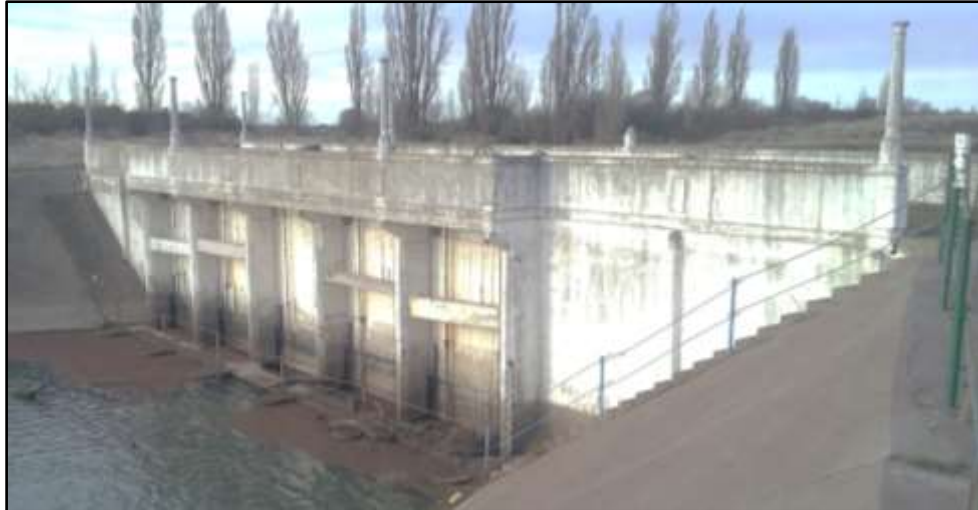
Foto 1. Obra de Toma, vista aguas arriba
