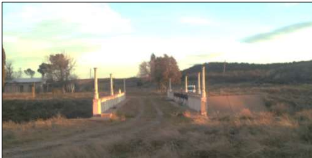
Foto 2. Obra de Toma, vista desde margen izquierda
