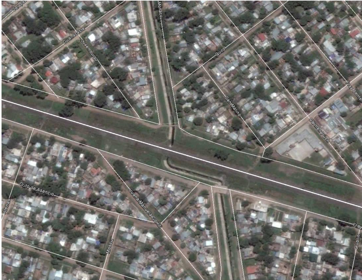
Foto 3.6. Vista del curso canalizado y su entorno.
