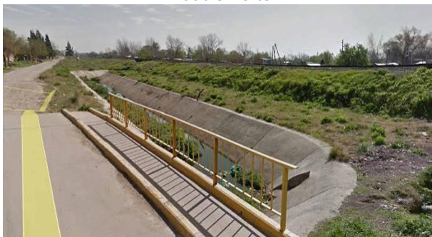
Foto 3.7. Cruce del canal con la traza del FCGSM, vista hacia el norte.
