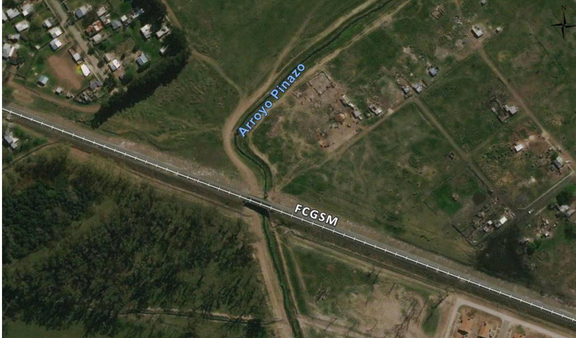
Foto 3.9. Vista del curso canalizado y su entorno.
