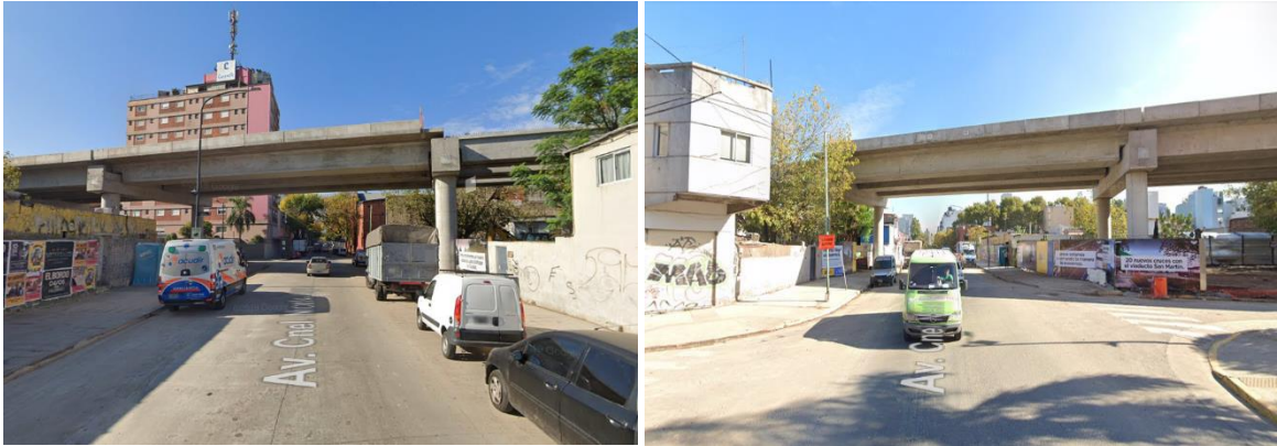
Fuente: Street View (2019).
