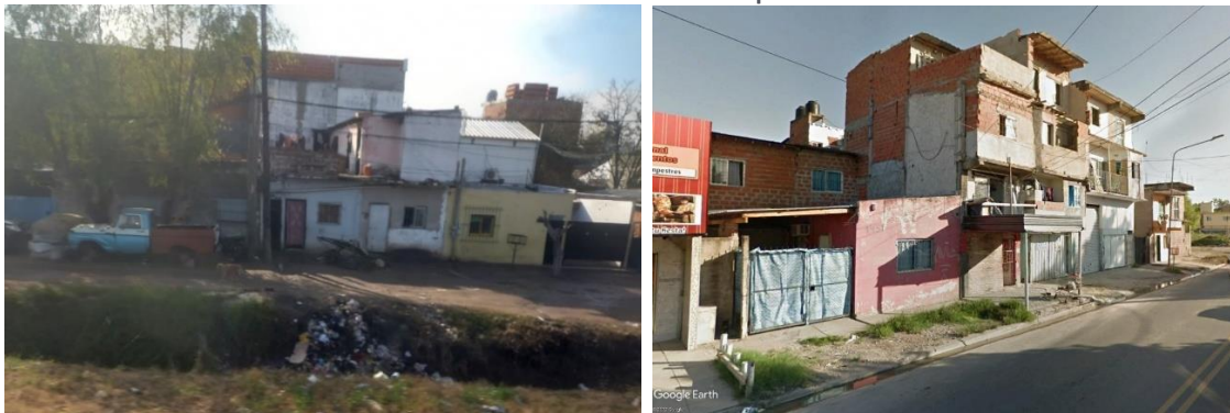
Fotos 3.34. Asentamiento Hospital.
