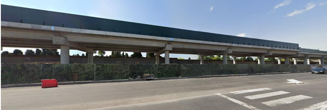
Fotos 3.73. Vista del viaducto elevado, lindero al Cementerio de Chacarita sobre Av. Warnes.
