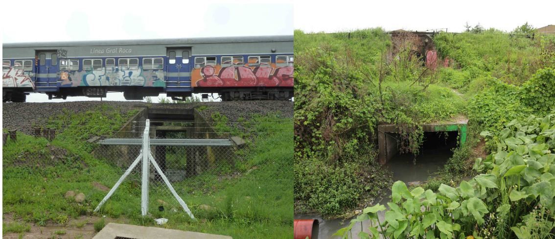
Fotos 45 y 46. Alcantarillas en el terraplén del FFCC Gral. Roca
