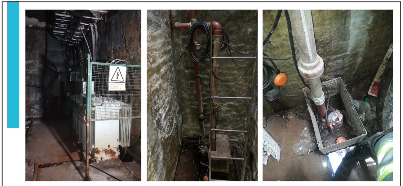
Figura N° 7.- Fotos estado cámaras
