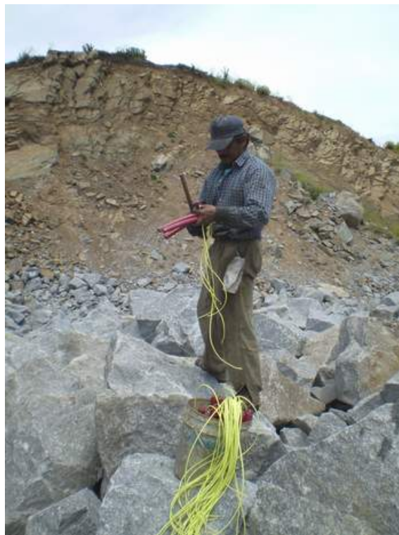
Colocación de cargas explosivas en las rocas
