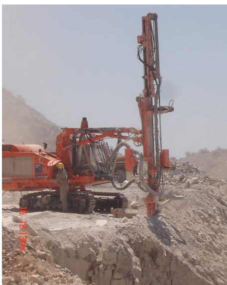
Perforadora de alto grado de tecnificación
