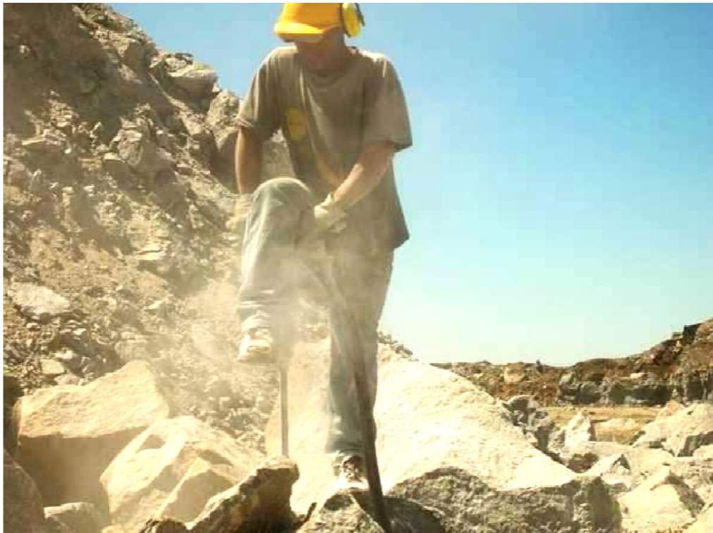
Perforación con martillo neumático, en donde se observa como se ayuda con la pierna para ejercer mayor fuerza
