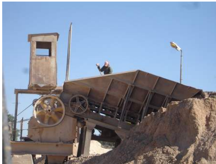
Operario dentro de la tolva destrabando las piedras
