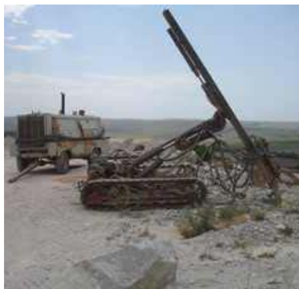
Perforadora alimentado por grupo moto compresor
