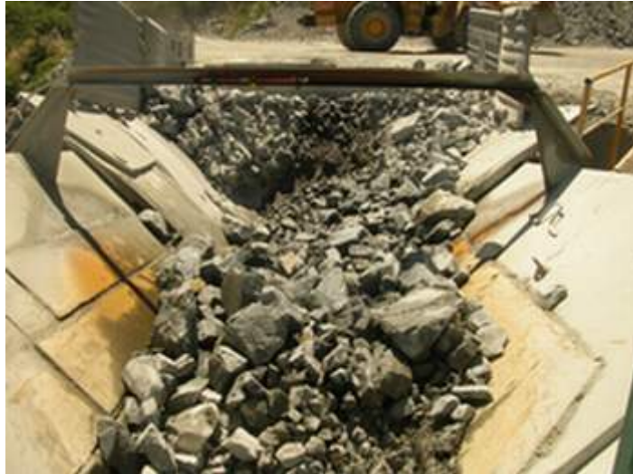
Tolva de trituración con rociadores de agua
