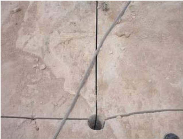
Vista de perforaciones vertical y horizontal
