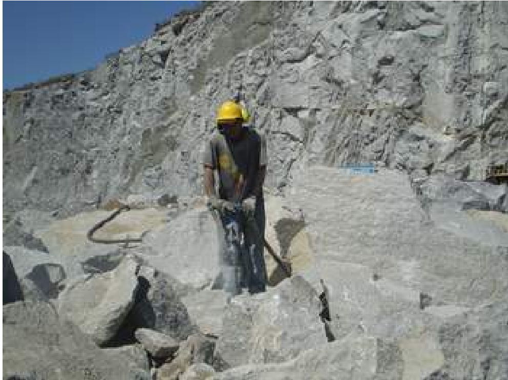
Patarrero realizando perforaciones
