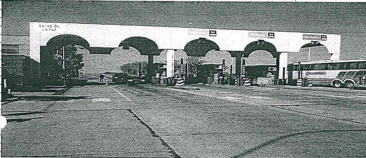
VISTA EXTERIOR ( Cabinas Descendente)
