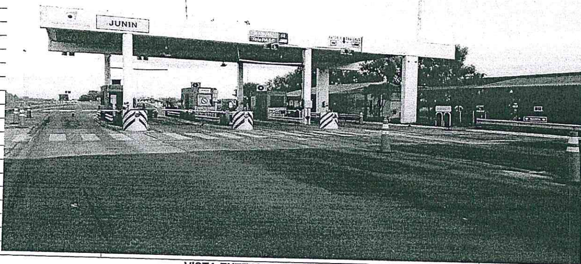
VISTA EXTERIOR ( Cabinas Descendente)
