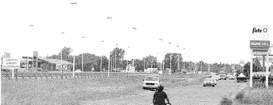
Colectoras en tramo urbano
