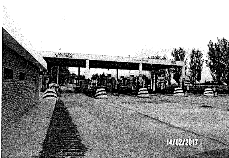
VISTA EXTERIOR (Lado Descendente)
