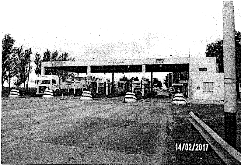
VISTA EXTERIOR (Lado Ascendente)
