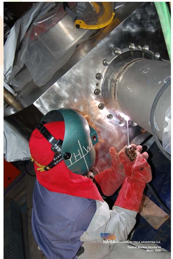
Soldador realizando tareas en la construcción de la Central Nuclear Atucha II situada en Lima - Provincia de Buenos Aires. (Fuente: Nucleoeléctrica Argentina S.A.)
