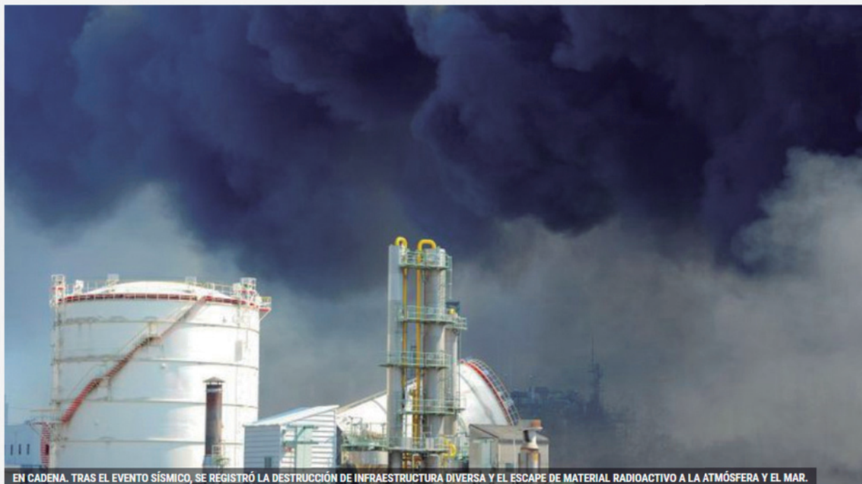
EN CADENA. TRAS EL EVENTO SÍSMICO, SE REGISTRÓ LA DESTRUCCIÓN DE INFRAESTRUCTURA DIVERSA Y EL ESCAPE DE MATERIAL RADIOACTIVO A LA ATMÓSFERA Y EL MAR.
