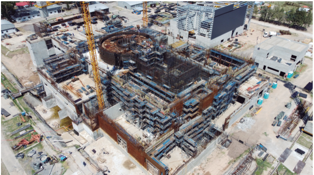
Avance de construcción del Reactor Prototipo CAREM 25 (Crédito CNEA, enero 2023)
