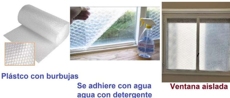
**Figura 30.** Plástico de burbujas para aislar las ventanas en el invierno o todo el año.
