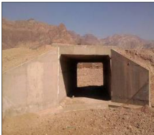
Alcantarilla guardaganado donde se ubica el inicio del tramo proyectado
