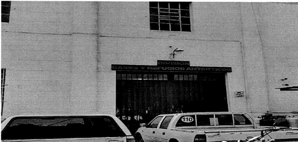
ENTRADA A LOS DEPOSITOS DE LA CAV
