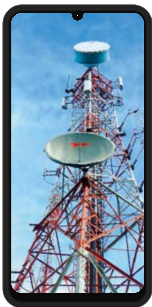
Compartición de infraestructura pasiva
