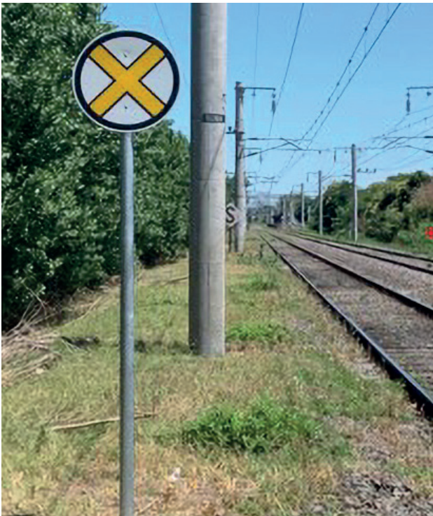
Figura 3. Disco aproximación en el ramal Plaza Constitución-La Plata de la línea Roca
