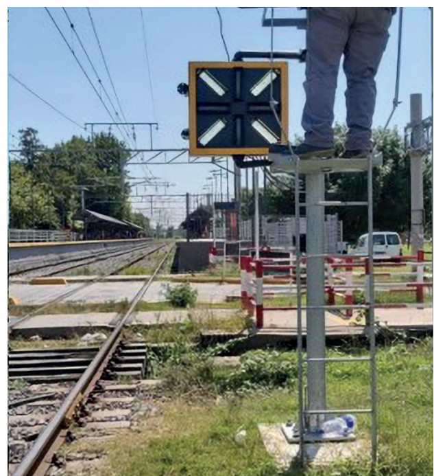
Figura 4. Instalación del Semáforo al Tren en el ramal Plaza Constitución-La Plata de la línea Roca
