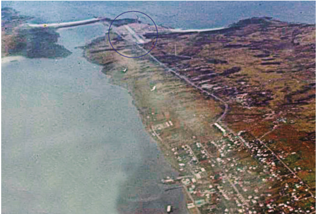
La pista de aluminio, obra del Grupo 1 de Construcciones en Hookers Point, a 2 km de Puerto Stanley
