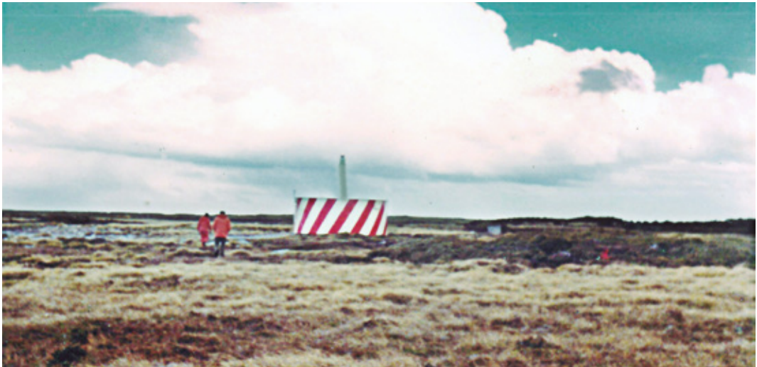
Radiofaro VOR instalado por la Fuerza Aérea Argentina en proximidades del aeropuerto de Puerto Stanley
