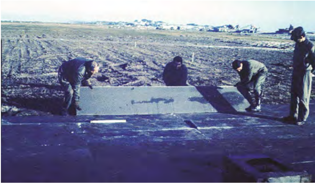
Colocación de planchas de aluminio en la BAM Malvinas - Gentileza: Com. VGM (R) Grünert
