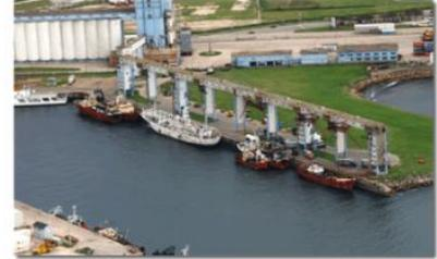
Consta de un Muelle de Hormigón de 276 mts. de longitud, dividido en dos Secciones 12da. y 13ra., cuyo frente en un largo de 250 mts. esta concesionado a la sociedad anteriormente citada. Este es utilizado para el atraque de buques de ultramar. Asimismo cuenta con un sector de conexión entre los Espigones n° 2 y n° 3, formado por un frente de 134 mts. de longitud denominado como Sección 11ma., en la que realizan operaciones de descarga y alistamiento embarcaciones pesqueras.
